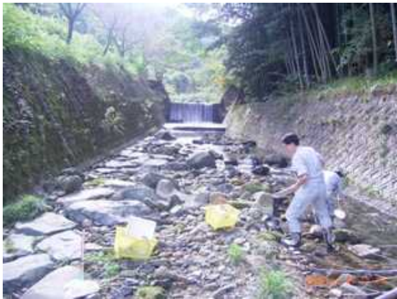
図2 上流域の一号橋
