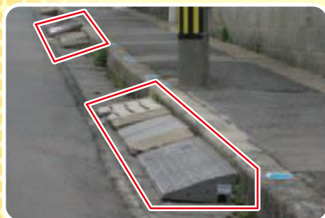
路上に置かれた乗り入れブロック
