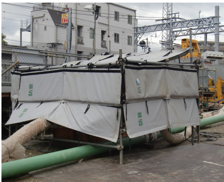
使用機械の防音シートによる養生
