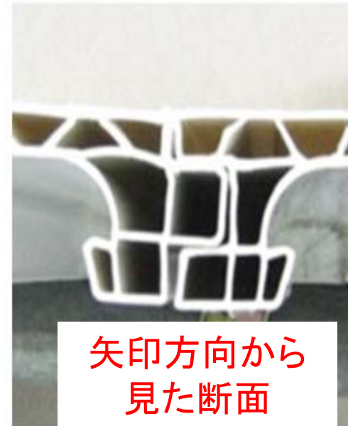
特殊PVC製遮音板による騒音対策
