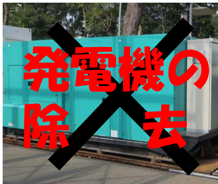
高圧受電設備使用による発電機の除去
