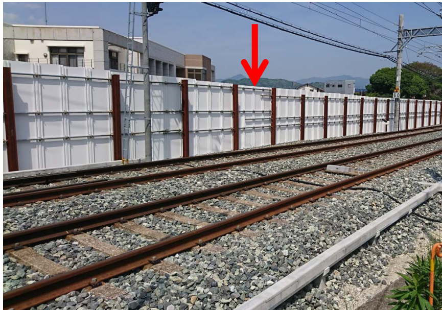
遮音板設置による騒音対策
