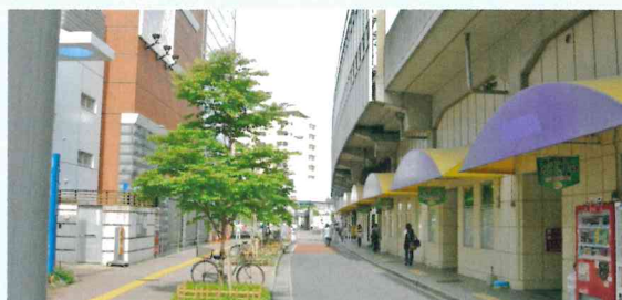
(福岡市営地下鉄 姪浜駅付近)
