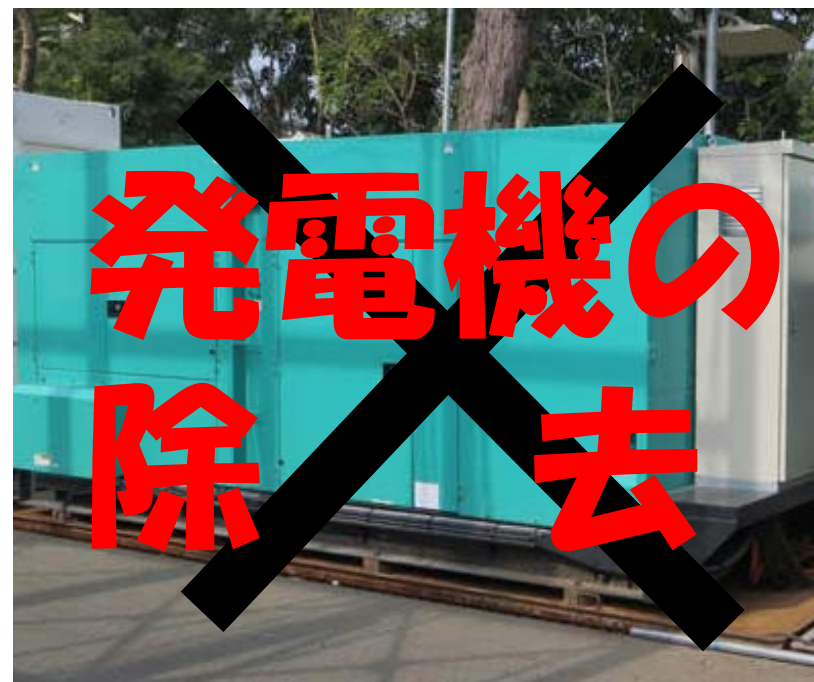
高圧受電設備使用による発電機の除去
