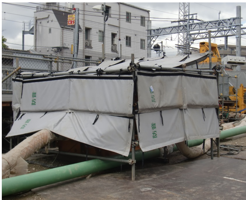
使用機械の防音シートによる養生
