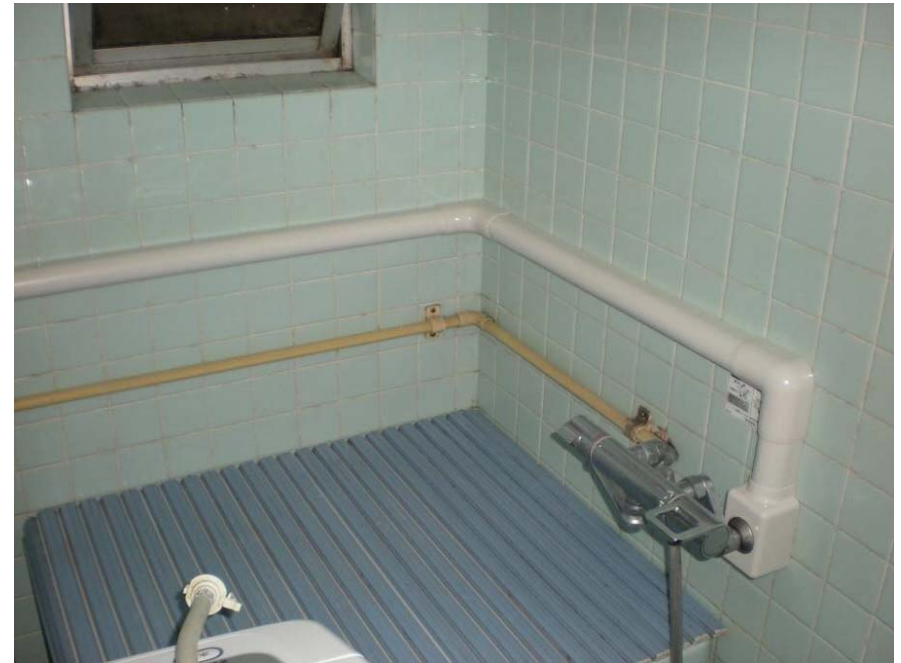
・浴室 給水管、給湯管、露出更新
