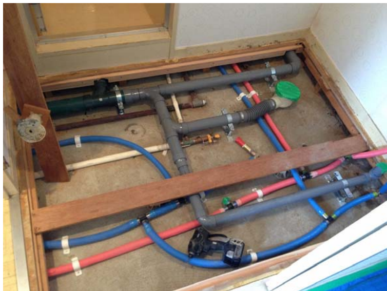
洗面脱衣室床下配管改修
