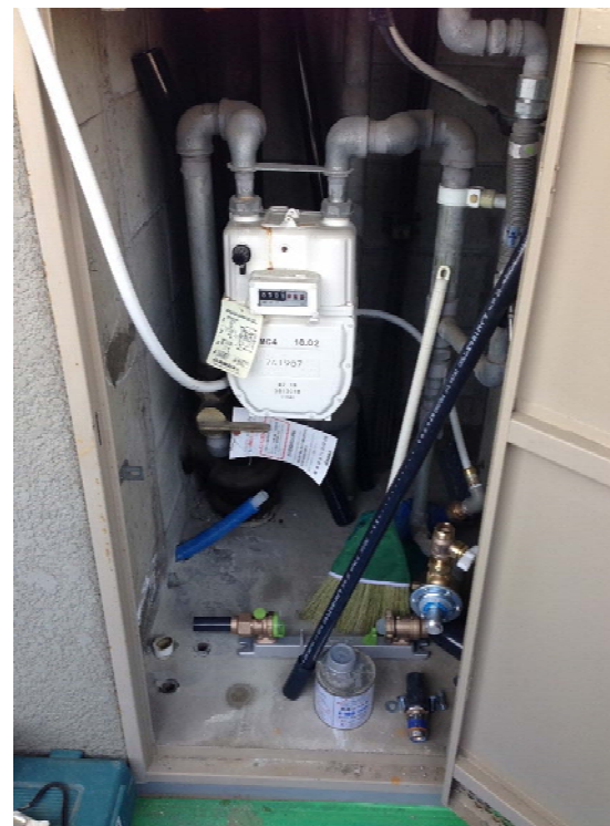
メーターボックス内給水管取替え
