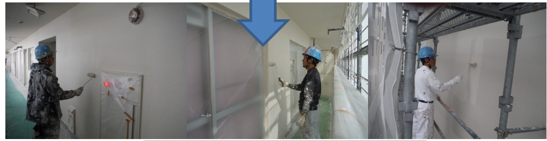
外壁・バルコニー・共用廊下 壁面塗装
