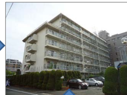
鋼製足場組立中
