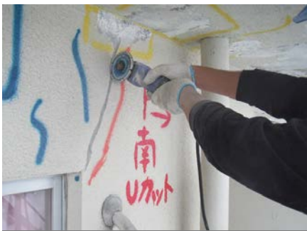
ひび割れ0.2mm以上の処理 Uカットシーリング工法
