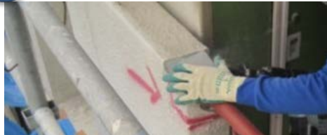
はつり・撤去状況
