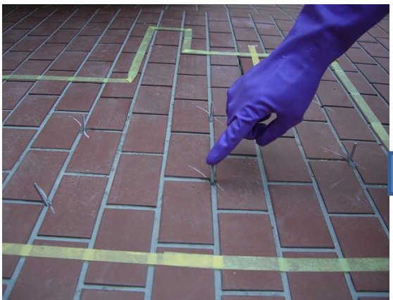
ステンレスピン挿入
