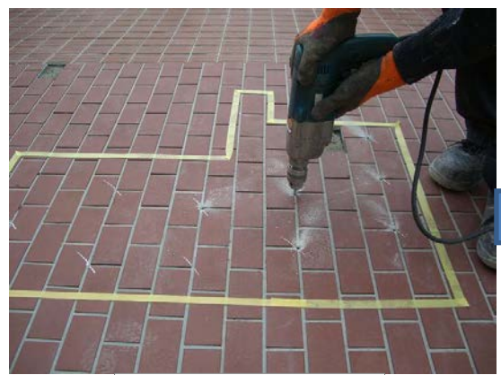
タイル目地に削孔
