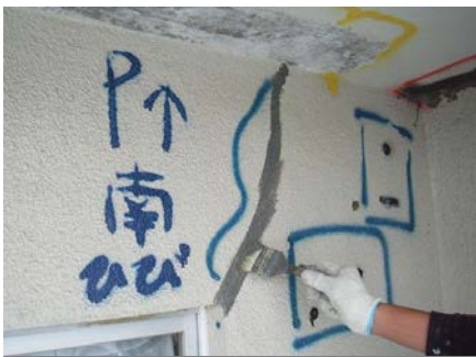
ひび割れ0.2mm未満の処理 フィラーすり込み工法
