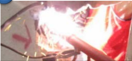
腐食部分溶接補修
