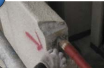
ステンレスピン挿入
