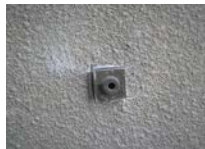
アタッチメント取付状況
