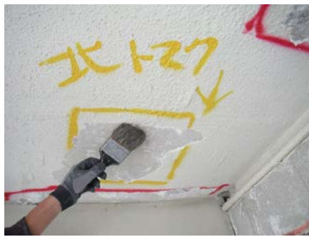
塗膜剥離処理 除去・肌合わせ工法
