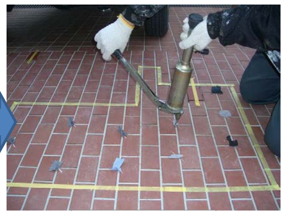
エポキシ樹脂注入
