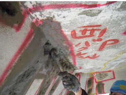
躯体爆裂・欠損処理 爆裂・欠損処理(リフリート工法)
