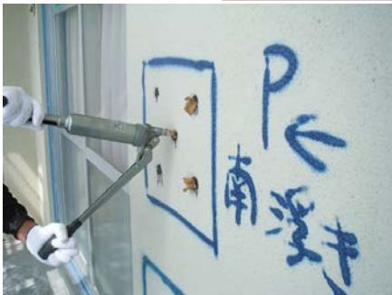
躯体モルタル浮きの処理 エポキシ樹脂注入工法
