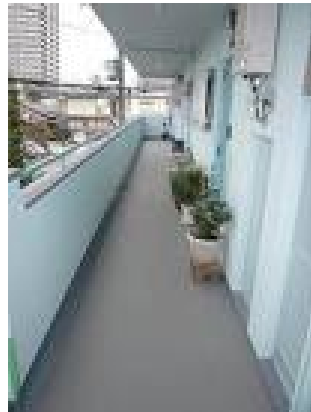
屋外の共用廊下
