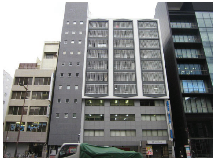
改修後 自然石調シート貼
