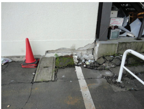
仙台市高砂14階建マンション 杭の破断
