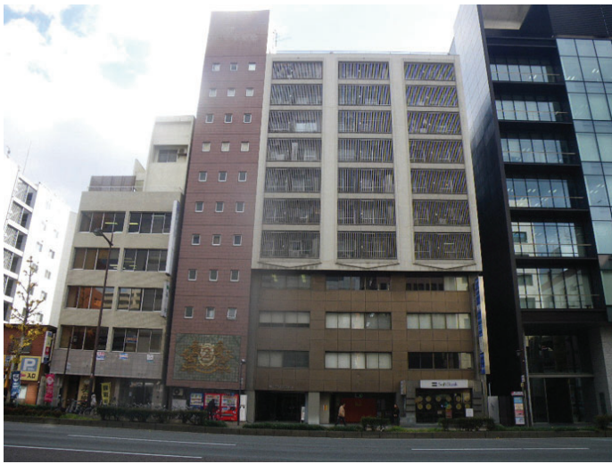
改修前 タイル貼
