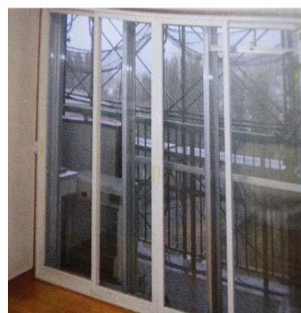
外窓工事前（3枚引き）
