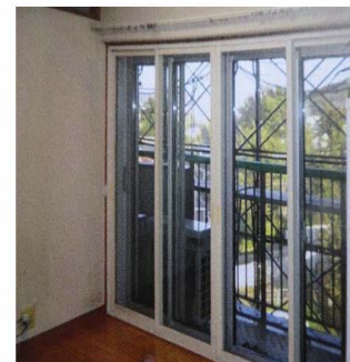
外窓工事後（4枚引き）
