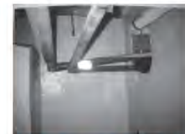
▲地下式受水槽内に配管されている飲用以外の配管
