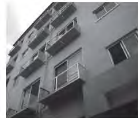
西側の外壁にステンレス製の空調室外機置き場新設した
