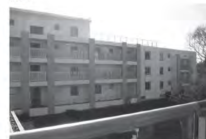
階段室型住棟を廊下型に改修。4階部分を一部減築。
