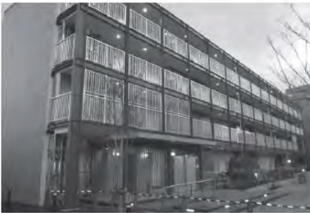
階段室型共用住宅を片廊下型にリノベーションしエレベーターと外部廊下を新設した事例
