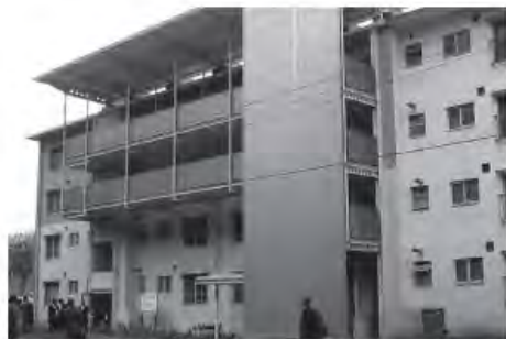
吊り構造としたことで部材が細く、軽快なファサードを実現している。
