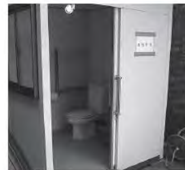
2 車椅子が使用できる大きさの 仮設トイレを設置した事例
