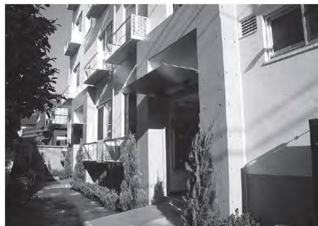
補強後（既存庇は撤去し、金属製庇に更新）
