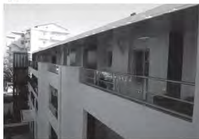
階段室型住棟を廊下型に改修し、エレベーターを設置。
