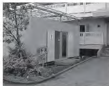
1 男女別の仮設便所を設置した団地 施錠ができる出入り口の中に プレハブトイレと手洗い器が 設置されている
