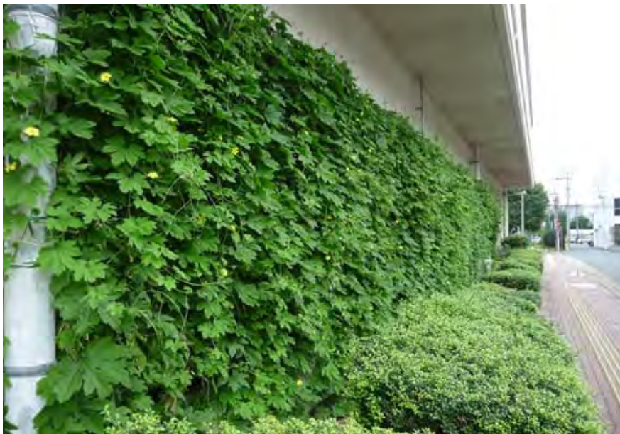
緑のカーテン(福岡市立障がい者スポーツセンター)
