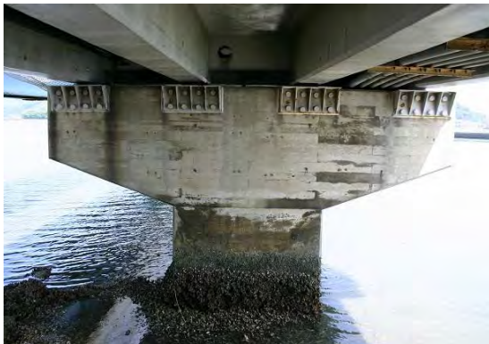
写真 3-8 T形式橋脚
