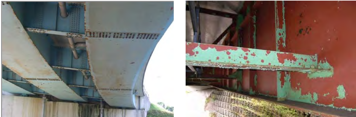
写真 4-1 塗装劣化の事例
