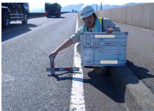
写真 7-2 路面の凹凸の変状事例
