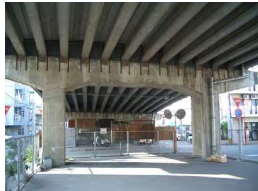
写真 3-9 ラーメン式橋脚
