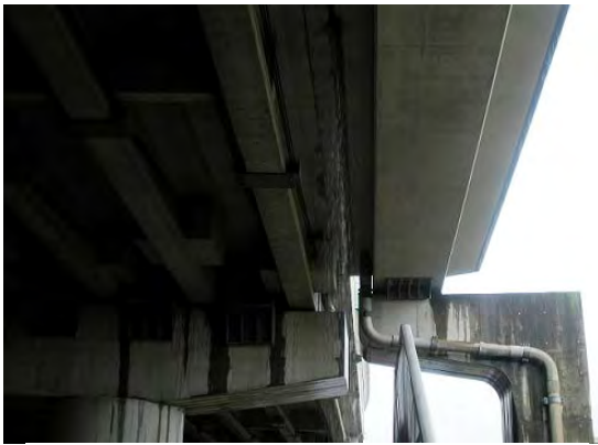
橋脚の桁受け部、縦目地部、橋脚の張出部
