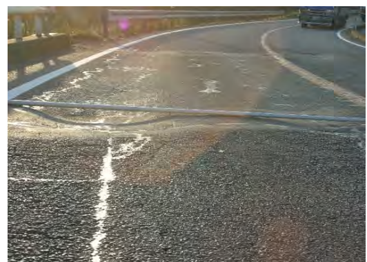
写真 7-2 路面の凹凸の変状事例
