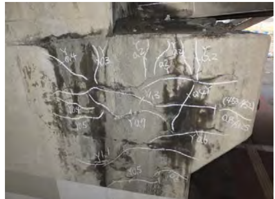
橋台の桁受け部
