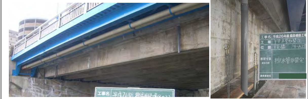
排水管垂れ流し部流末処理の例
