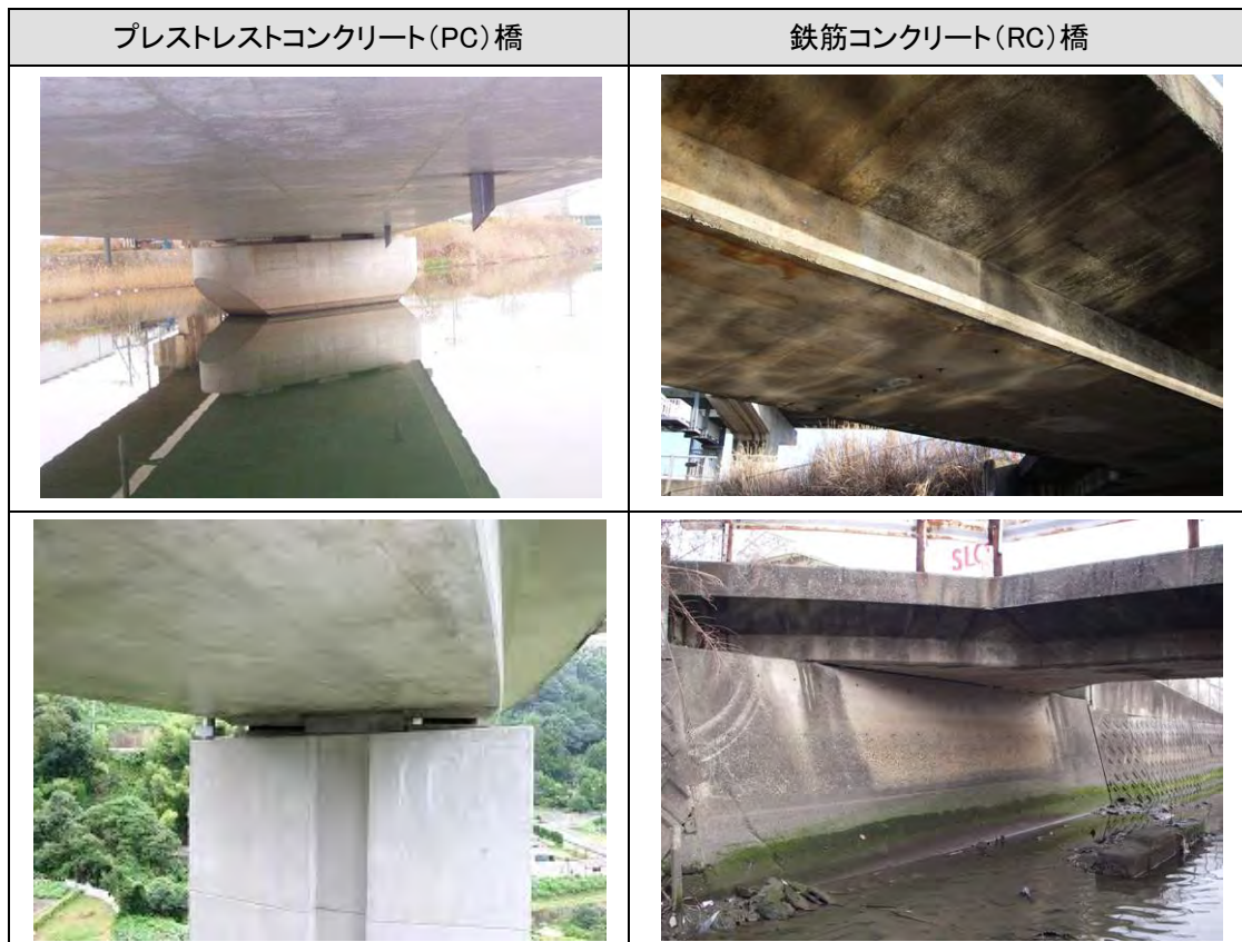
写真 3-4 箱桁橋 上部工
