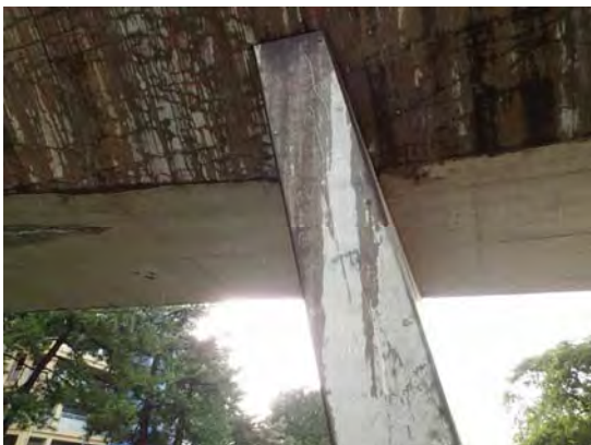
床版側面部、ラーメン橋脚
