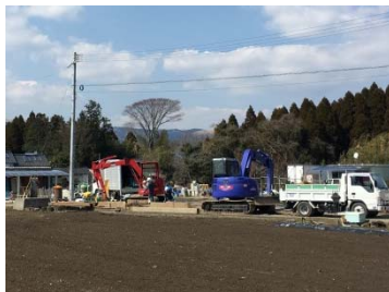
下水道の復旧が進む現場
