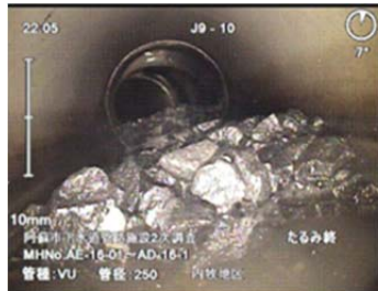
陥没箇所のTVカメラ画像（内牧地区）
