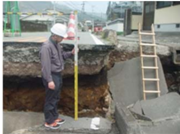
県道内牧停車場線（狩尾地区）
