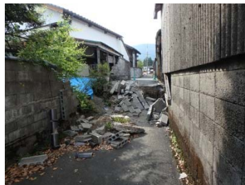
大きく地割れした断層部
