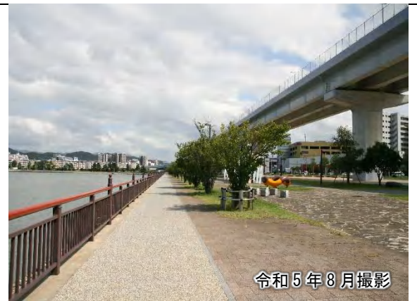
海岸沿いのウォーキングコース（既設）
