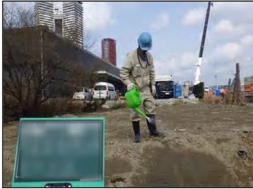
写真②-1 粉じん飛散防止剤の散布
