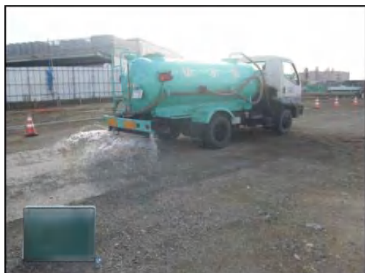
写真①- 1 施工ヤードへの散水
