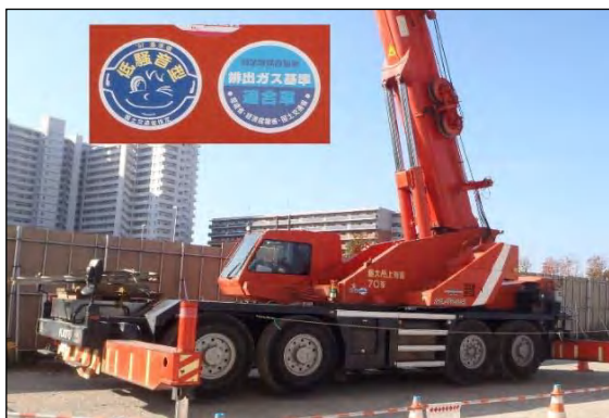
写真②-5 低騒音型建設機械の使用状況
