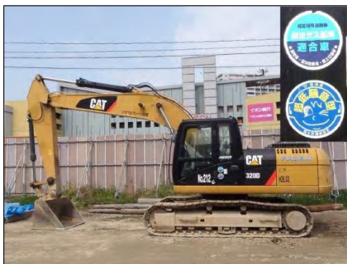
写真①-4 低騒音型建設機械の使用状況
