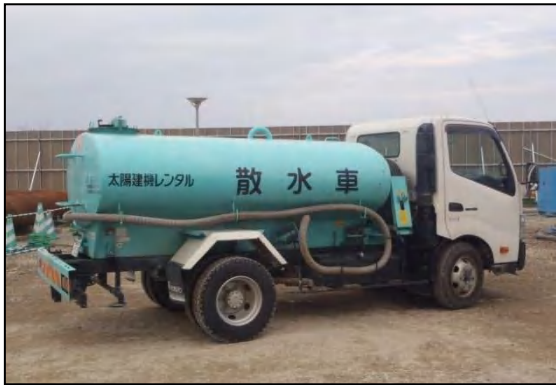
写真②-1 施工ヤードへの散水設備
