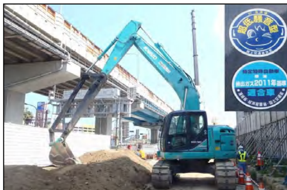
写真①-4 低騒音型建設機械の使用状況
