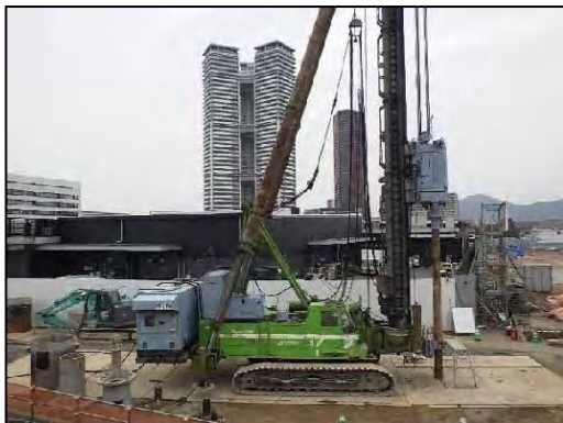
写真⑤-3 低騒音型建設機械の使用状況 (全景)
