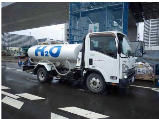
写真⑤-1 施工ヤードの散水設備
