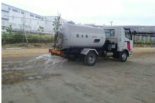
写真③-1 施工ヤードの散水状況
