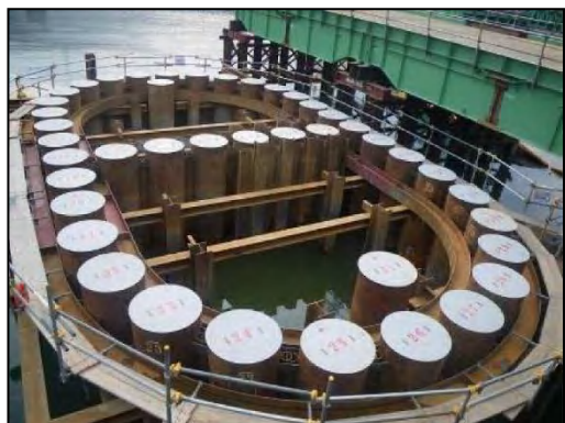
写真②-7 鋼管矢板による橋脚下部の囲い込み
