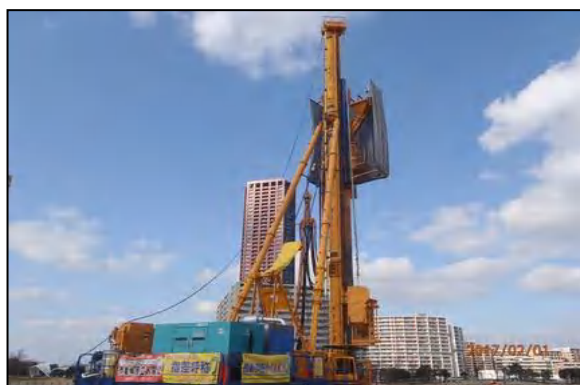
写真①- 5 低騒音・無振動工法の採用
