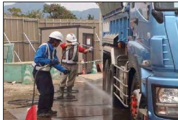
写真②-6 工事用車両のタイヤ洗浄状況
