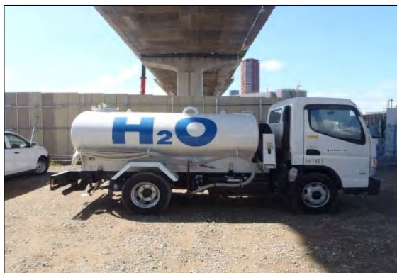
写真②-1 施工ヤードへの散水設備
