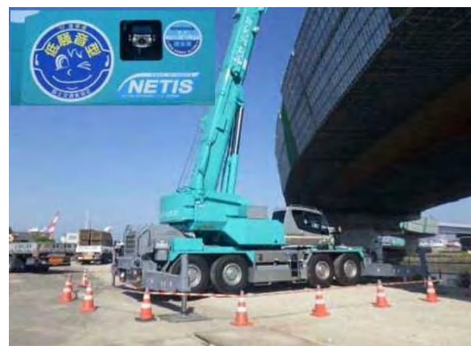
写真④-4 低騒音型建設機械の使用状況 3
