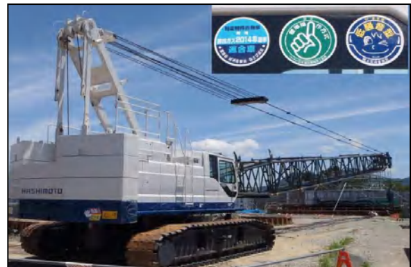
写真③-4 低騒音型建設機械の使用状況
