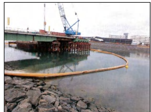
写真②-8 汚濁防止膜の展張
