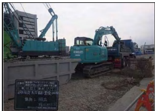
写真⑤-7 発生土の積込状況
