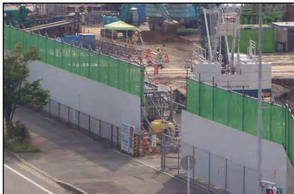
写真③-3 防音パネル等の遮音対策
