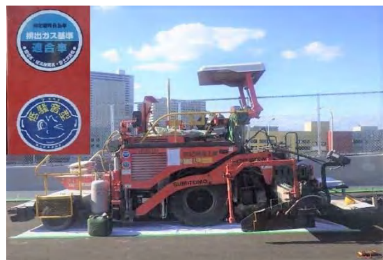
写真⑥-4 低騒音型建設機械の使用状況 2
