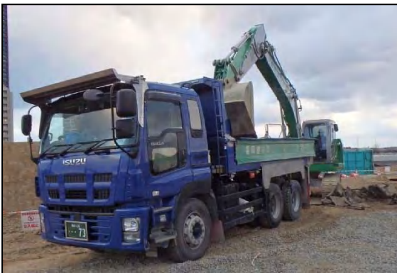
写真③-7 アスファルト塊の積込状況
