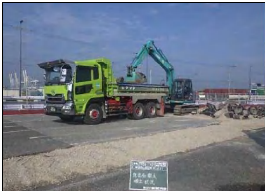
写真⑤-5 アスファルト塊の積込状況
