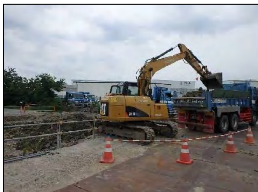
写真④-6 建設汚泥の積込状況
