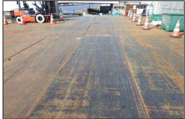
写真④-2 敷鉄板の設置による防じん対策
