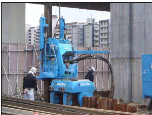
写真①-5 低振動工法の用
