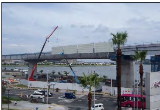
写真②-3 防音用落下防護柵の設置
