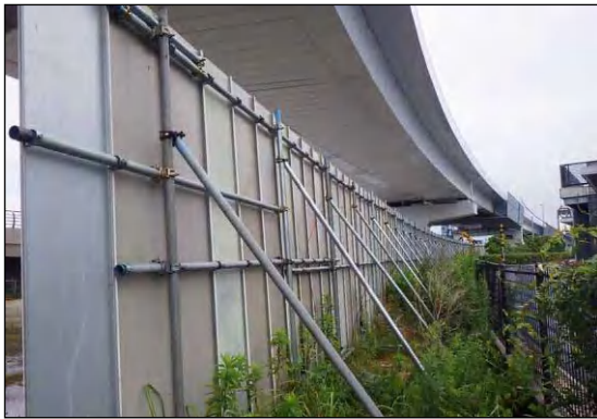
写真⑤-3 防音パネル等の遮音対策
