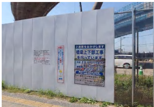
写真①-4 防音パネルの設置による遮音対策
