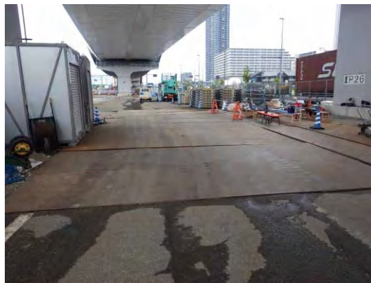
写真⑤-6 敷鉄板の設置による粉じん対策
