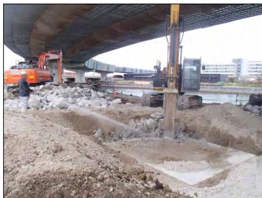
写真④-1 施工ヤードへの散水
