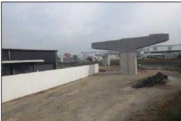
写真⑤-3 仮囲いの設置による遮音対策
