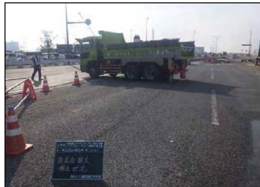
写真⑤-6 アスファルト塊の運搬状況
