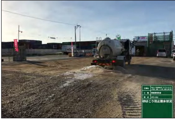
写真⑤-1 施工ヤードへの散水状況
