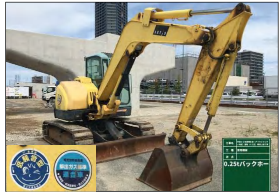
写真⑤-4 低騒音型建設機械の使用状況
