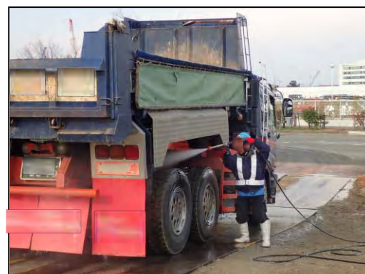
写真①- 6 工事用車両のタイヤ洗浄
