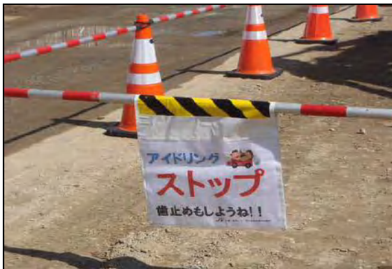
写真①-3 建設機械の取り扱いの啓発状況
