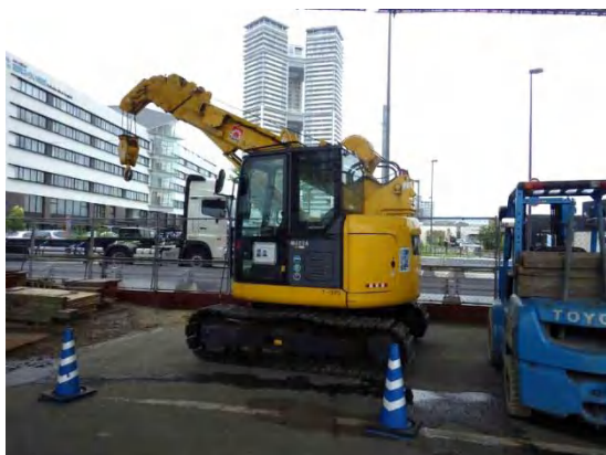
写真⑤-5 低騒音型建設機械の使用状況 3
