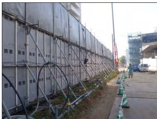
写真①-3 防音パネルの設置
