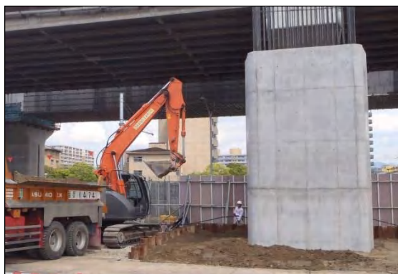
写真①-7 発生土での埋戻し
