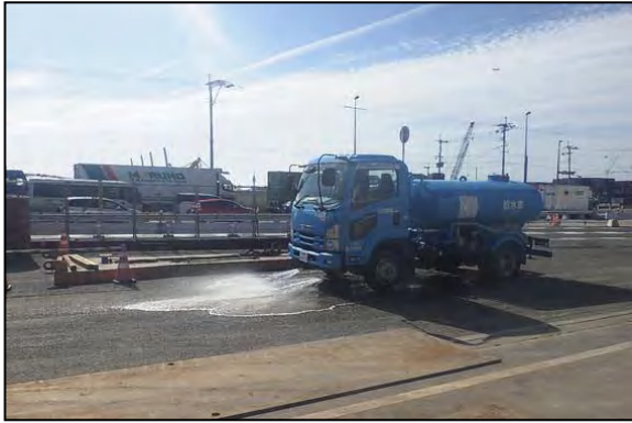
写真⑤-1 施工ヤードへの散水状況
