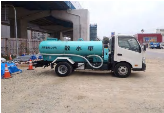
写真⑥-1 施工ヤードの散水設備
