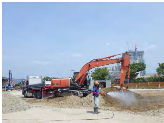
写真③-2 散水状況
