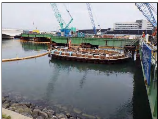
写真④-5 汚泥防止膜の展張状況
