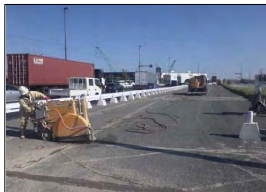
写真⑤-8 建設汚泥の回収状況
