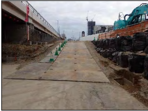
写真⑤-1 敷鉄板の敷設状況
