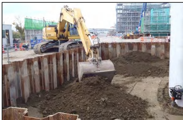
写真③-7 発生土による埋戻し
