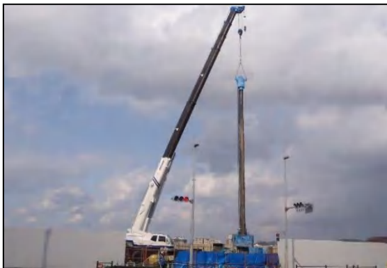
写真②-5 低振動工法（鋼矢板圧入工法）
