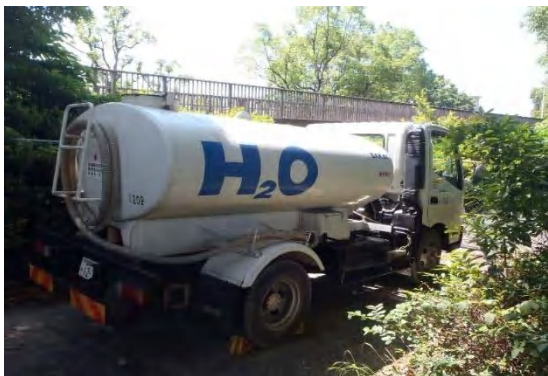
写真①-1 施工ヤードの散水設備
