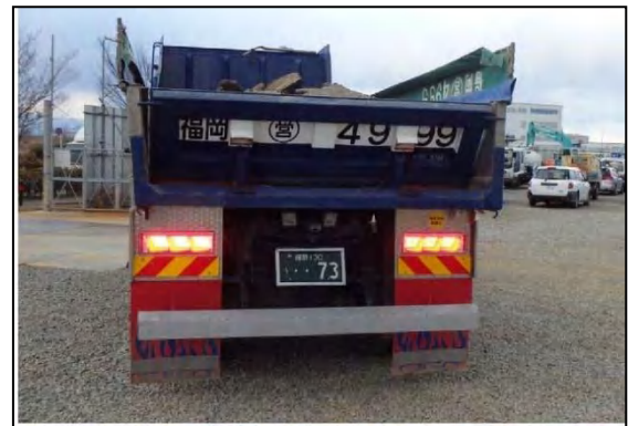
写真③-8 アスファルト塊の運搬状況
