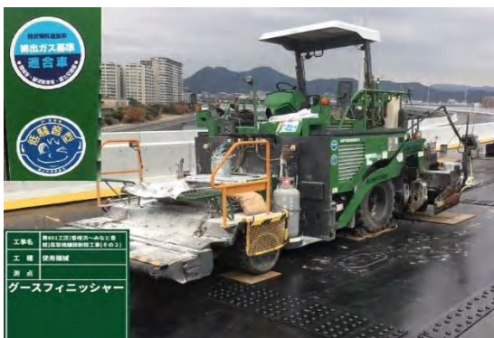
写真⑥-5 低騒音型建設機械の使用状況 3
