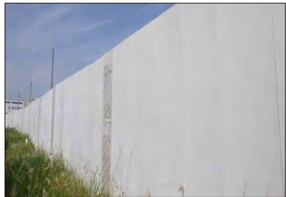
写真③-6 防音パネルの設置
