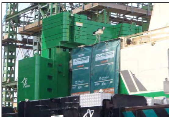
写真②-4 エンジン部の防音シートの設置
