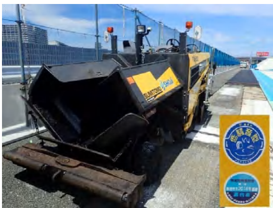
写真⑥-3 低騒音型建設機械の使用状況 1
