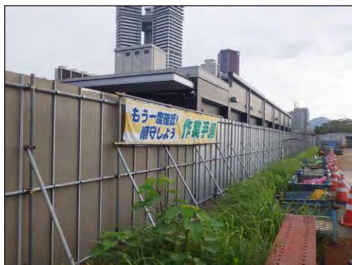
写真④-3 防音パネル等の遮音対策
