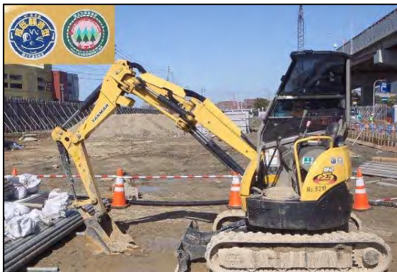
写真①-5 低騒音型建設機械の使用状況
