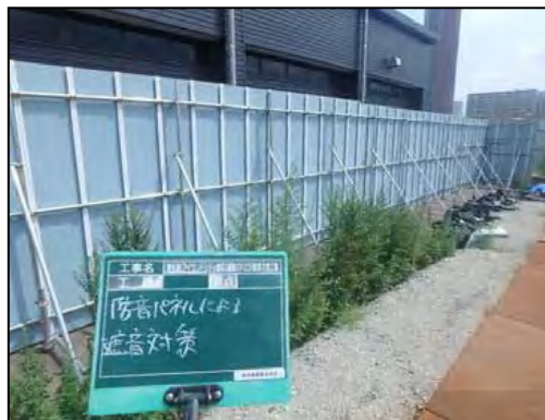
写真④-2 防音パネル等の遮音対策
