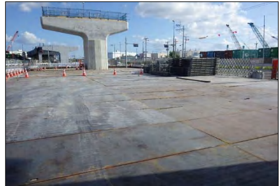
写真⑤-6 敷鉄板の設置による粉じん対策状況
