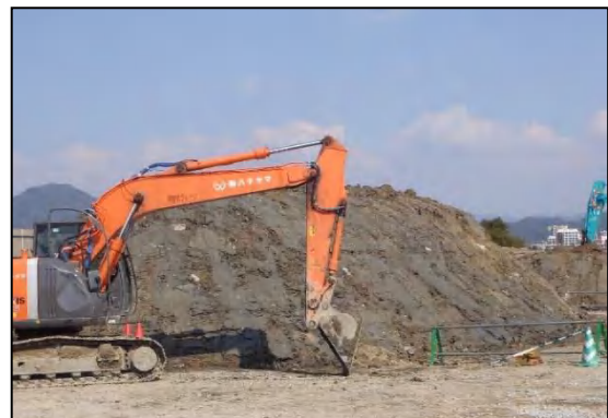
写真②-8 発生土の仮置き
