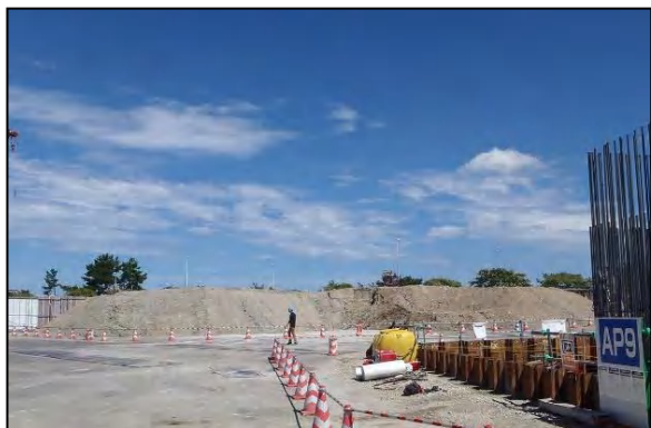
写真①-7 発生土の仮置き
