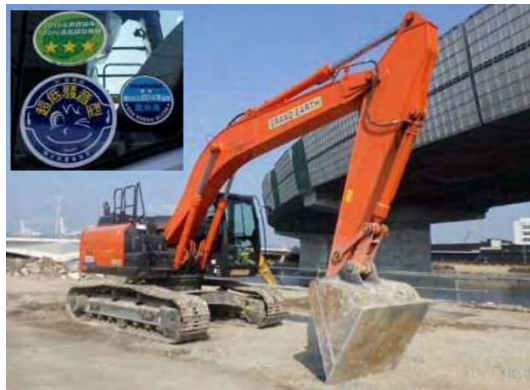
写真④-2 低騒音型建設機械の使用状況 1
