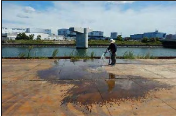
写真④-1 施工ヤードへの散水
