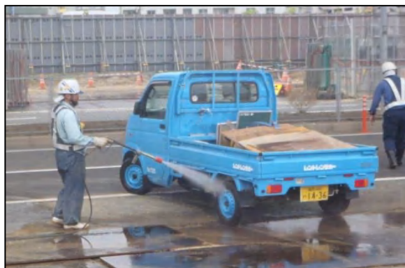
写真①-6 工事用車両のタイヤ洗浄状況
