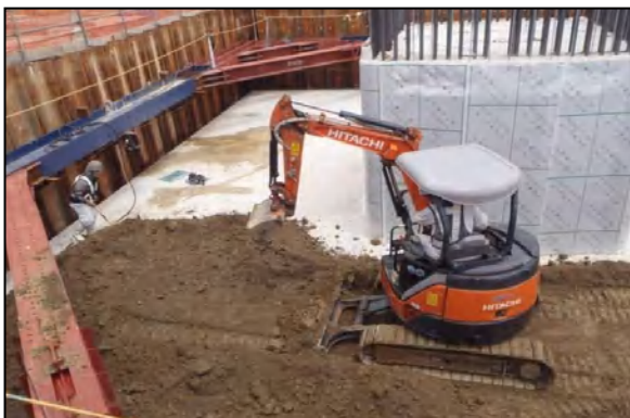
写真②-7 発生土による埋戻し
