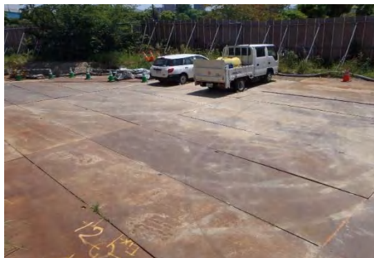
写真①-6 敷鉄板の設置による粉じん対策
