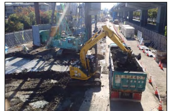
写真①-8 建設汚泥の積込状況
