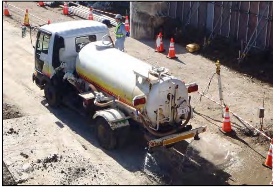
写真①-1 施工ヤードへの散水状況
