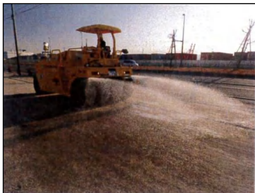
写真③-1 施工ヤードへの散水
