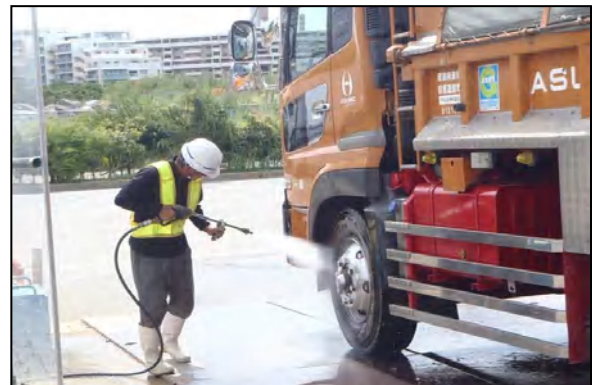
写真③-6 工事用車両のタイヤ洗浄状況
