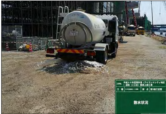
写真③-1 施工ヤードへの散水状況
