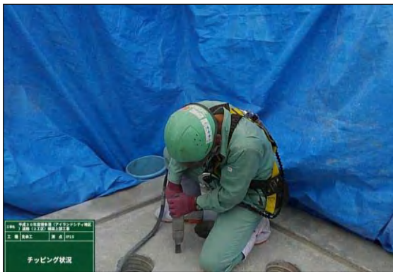
写真③-5 沓座チッピング作業時の粉じん対策（内側）
