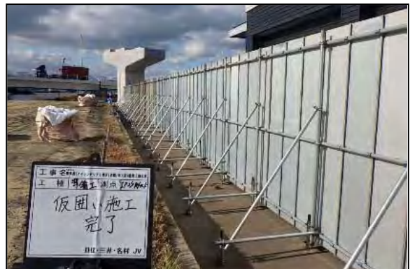
写真④-4 仮囲いの設置による遮音対策
