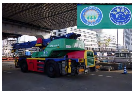
写真⑤-4 低騒音型建設機械の使用状況 2
