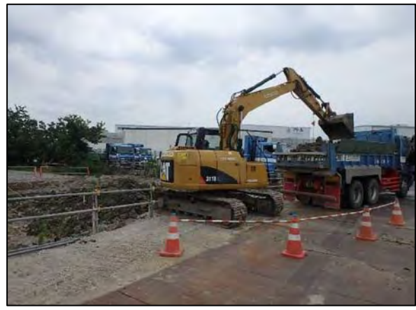
写真④-6 建設汚泥の積込状況
