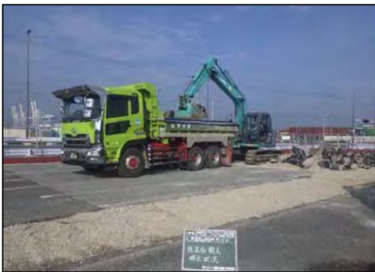
写真⑤-5 アスファルト塊の積込状況
