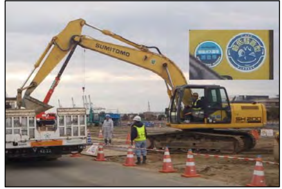
写真③-4 低騒音型建設機械の使用状況
