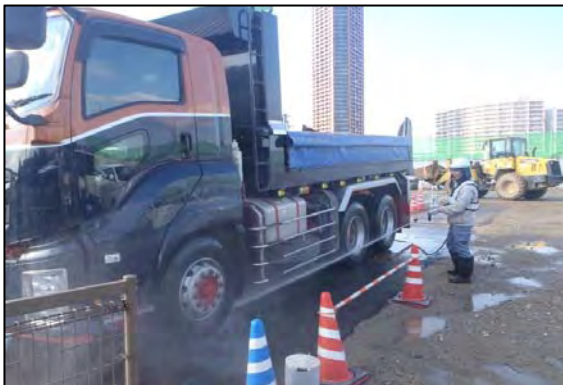
写真③-5 工事用車両のタイヤ洗浄状況
