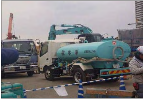
写真③-1 施工ヤードへの散水設備
