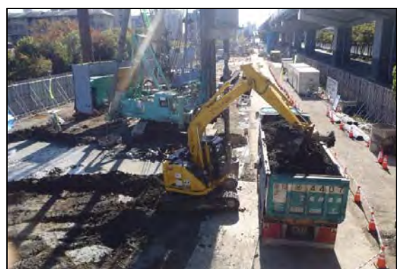
写真①-8 建設汚泥の積込状況
