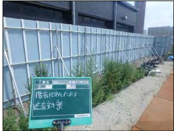
写真④-2 防音パネル等の遮音対策
