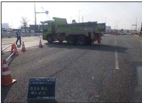
写真⑤-6 アスファルト塊の運搬状況
