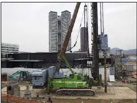
写真⑤-3 低騒音型建設機械の使用状況
