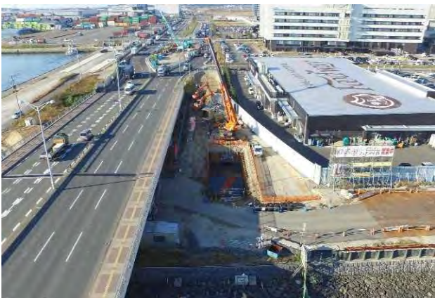
工事進捗状況写真
