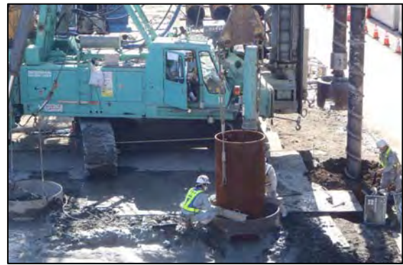
写真①-6 低振動工法 (鋼管ソイルセメント杭工法)
