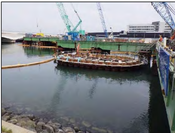
写真④-5 汚泥防止膜の展帳状況
