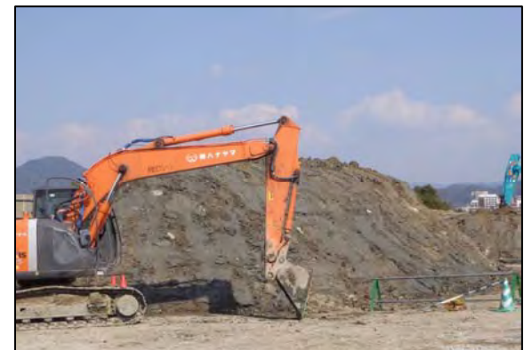
写真②-8 発生土の仮置き
