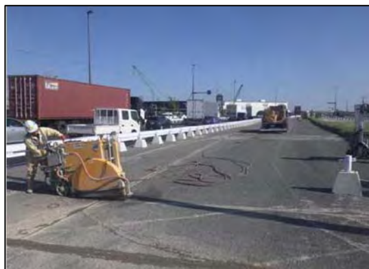
写真⑤-8 建設汚泥の回収状況
