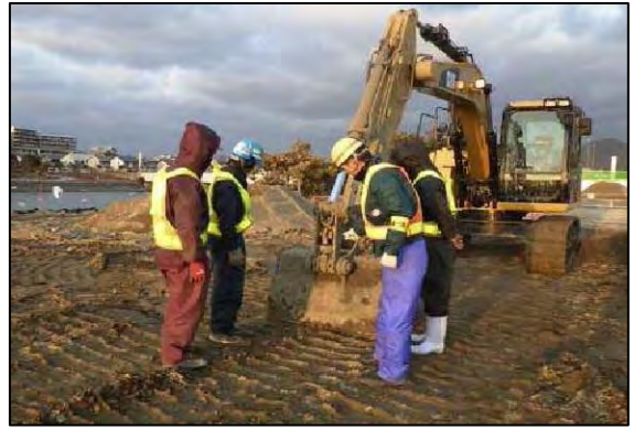
写真③-2 建設機械の取り扱いの指導状況
