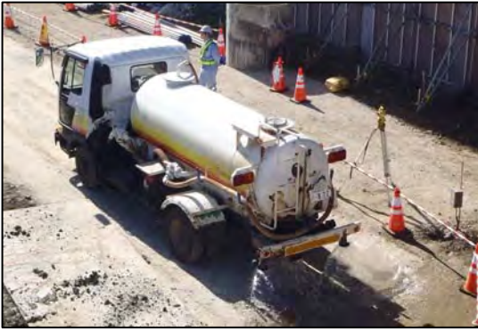
写真①-1 施工ヤードへの散水状況
