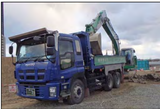
写真③-7 アスファルト塊の積込状況
