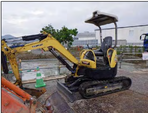
写真④-3 低騒音型建設機械の使用状況
