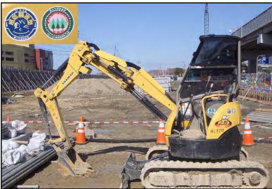
写真①-5 低騒音型建設機械の使用状況
