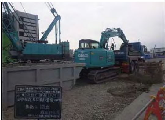
写真⑤-7 発生土の積込状況
