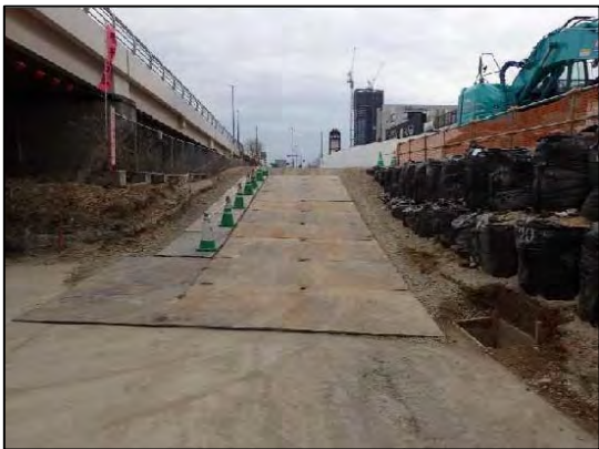
写真⑤-1 敷鉄板の敷設状況
