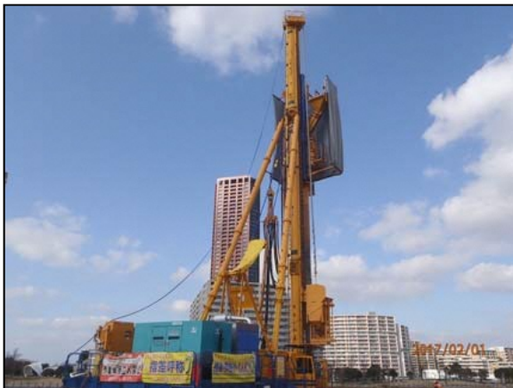
写真①-5 低騒音・無振動工法の採用
