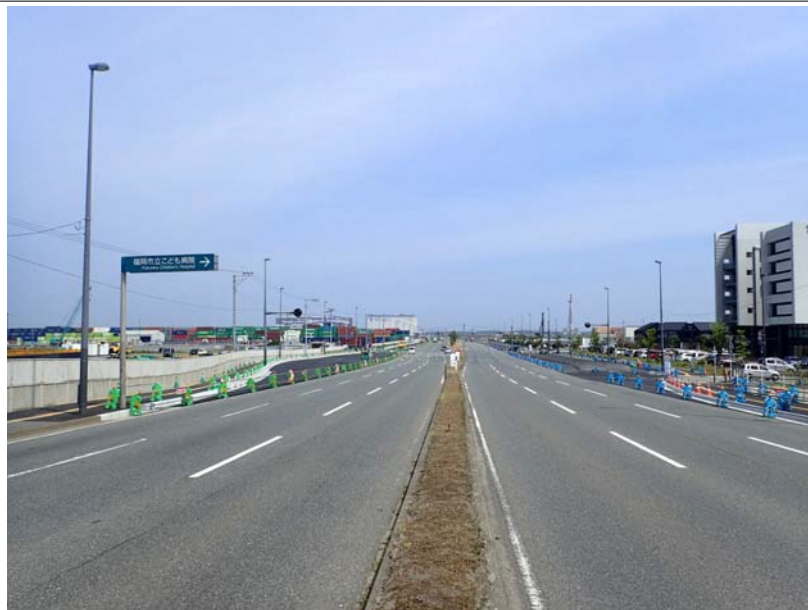
工事進捗状況写真
