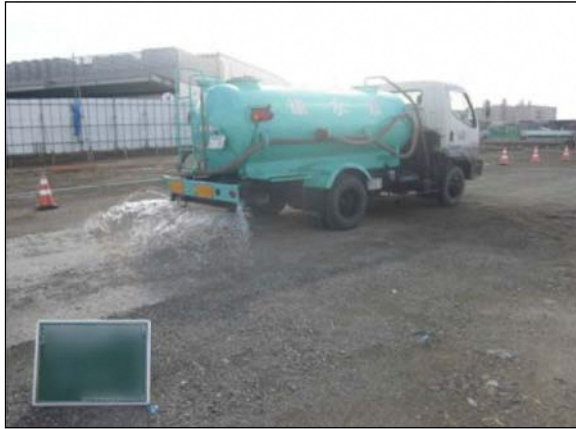
写真①-1 施工ヤードへの散水
