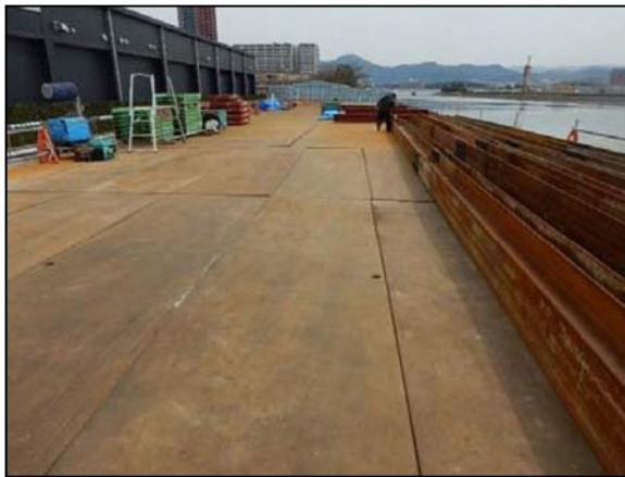
写真②-5 敷鉄板の設置
