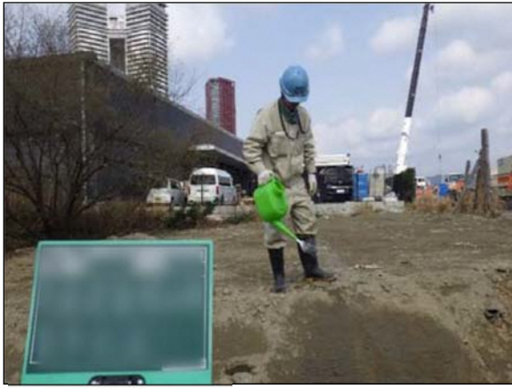
写真②-1 粉じん飛散防止剤の散布
