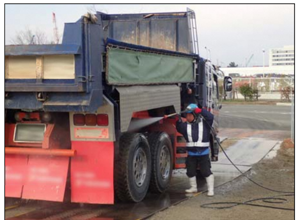
写真①-6 工事用車両のタイヤ洗浄
