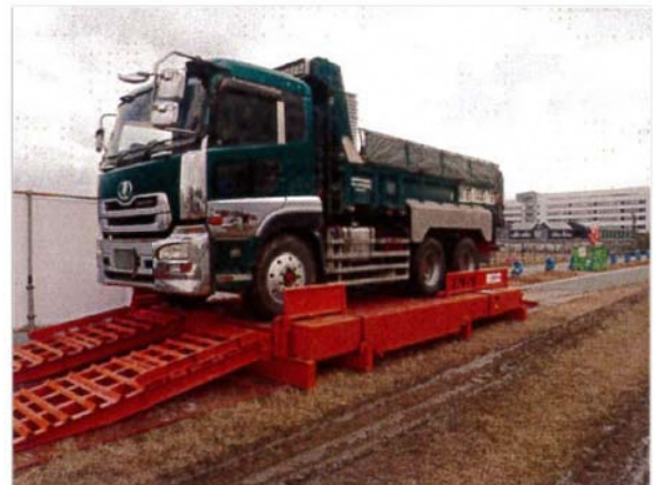
写真③-4 工事用車両のタイヤ洗浄（乾式）
