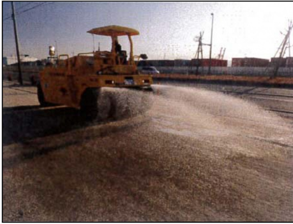
写真③-1 施工ヤードへの散水
