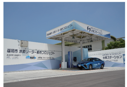
福岡市中部水処理センター内 下水汚泥消化ガス水素ステーション
