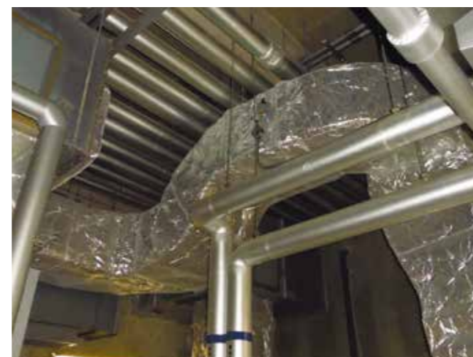
還気ダクトの新設
