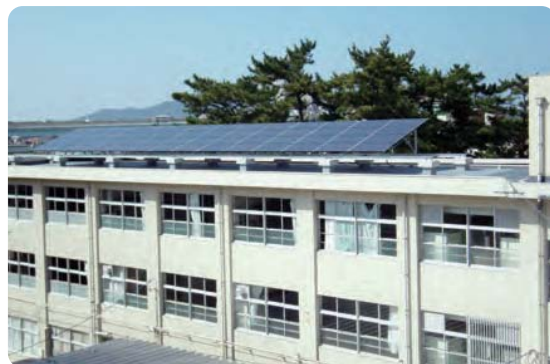
設置している太陽光発電設備
