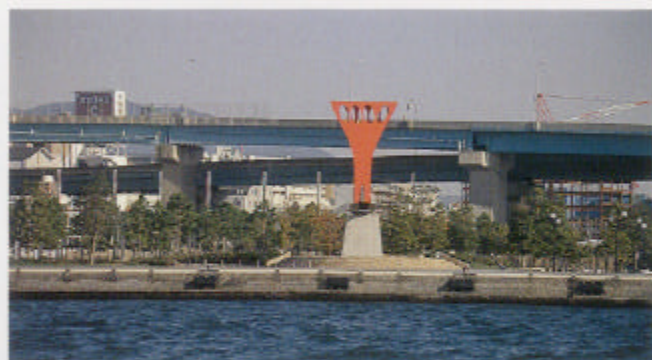
海辺に沿って延びる都市高速道路。都市機能を支える重要な役割を担っているが、景観的には視界の妨げになっているという問題点もある。
