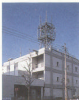
過去の建設例 形態自体のバランスの悪さと鉄骨部材の多さによる煩雑さが目立つ。
