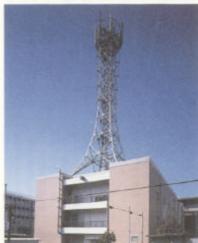
今回建設された鉄塔の全景 上層中ほどに見える4本のリングを 取りつけることによって、鉄骨部材 の煩雑さが軽減されている。
