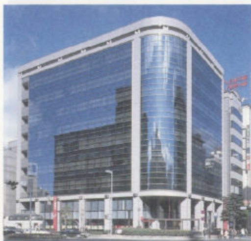
福岡ダイヤモンドビルの全景 低層部は石造の柱と独立柱のようにきわだたせ、上層部では石とガラスカーテンウォールのすっきりとしたデザインで構成されている。
