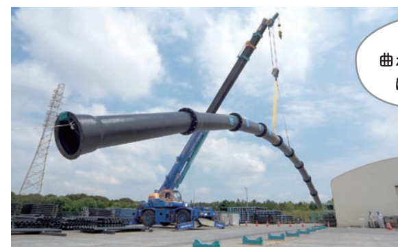
<耐震管の吊り上げ実験の様子>
