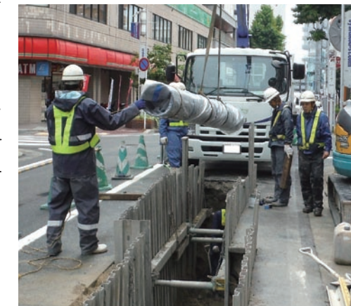
<配水管の埋設工事の様子>
