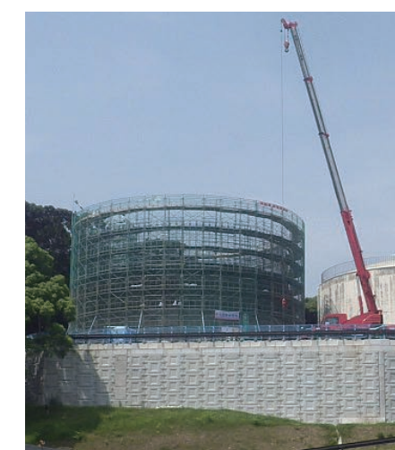
<新しい配水池の工事の様子>
