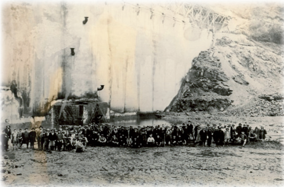
第1期拡張工事直後の曲淵ダム 昭和9年
