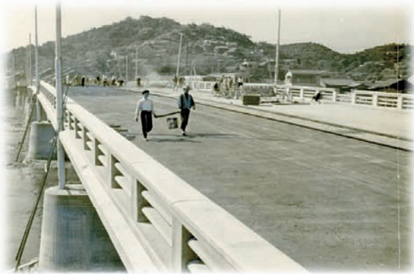
室見橋の架け替え工事★ 昭和33年
