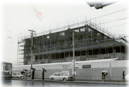
西支所(西区役所→早良区役所)建設工事中 昭和45年4月
