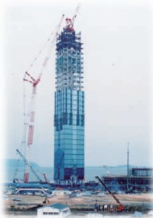
建設中の福岡タワー
