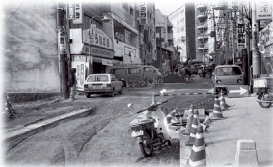
オレンジ通り道路改良工事中 昭和60年
