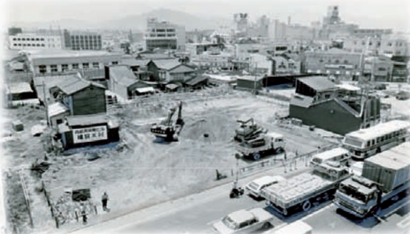
西新再開発整地工事★ 昭和52年
