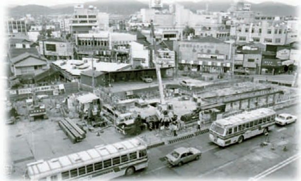
西新再開発建設工事着手★ 昭和54年
