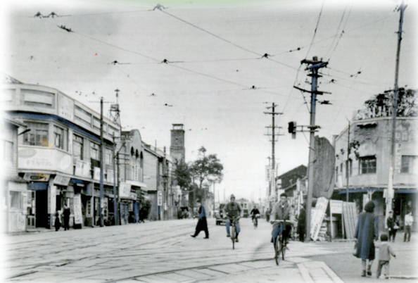
国道202号西新交差点★ 昭和25年
