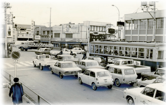
国道202号脇山口交差点★ 昭和44年
