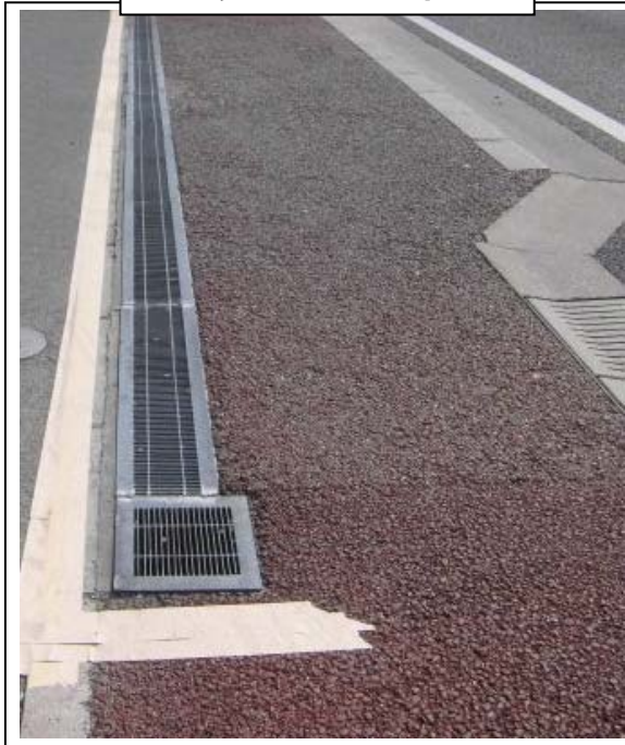
現場状況（近景）
