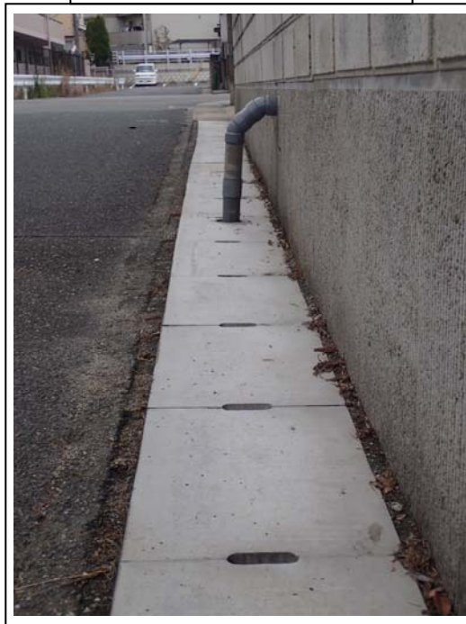
補修後の状態
