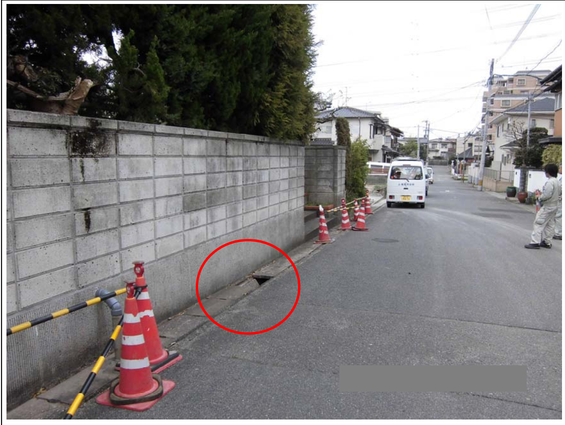
現場状況（遠景）
