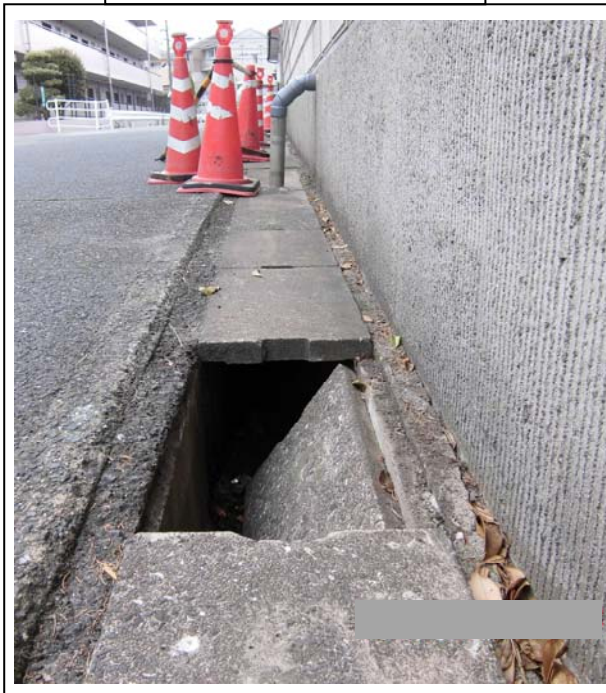
現場状況（近景）
