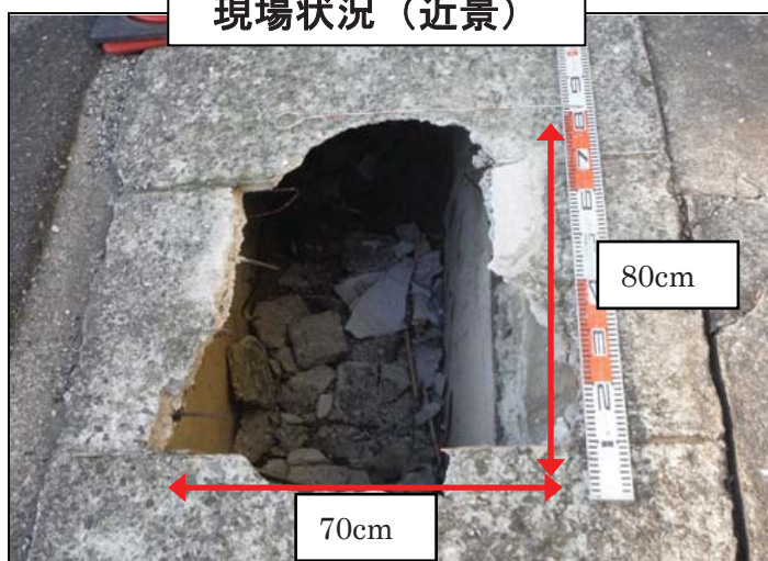
現場状況（近景）
