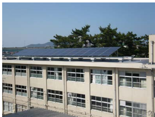
設置している太陽光発電設備
