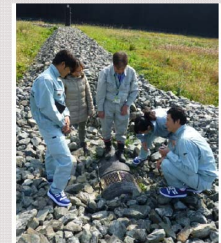
浸出水集排水管幹線の確認 (場所: 西部(中田)埋立場)
