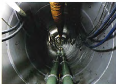
長距離施工イメージ Image of a long distance pipeline construction
