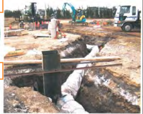
■一体化長さの埋設試験
