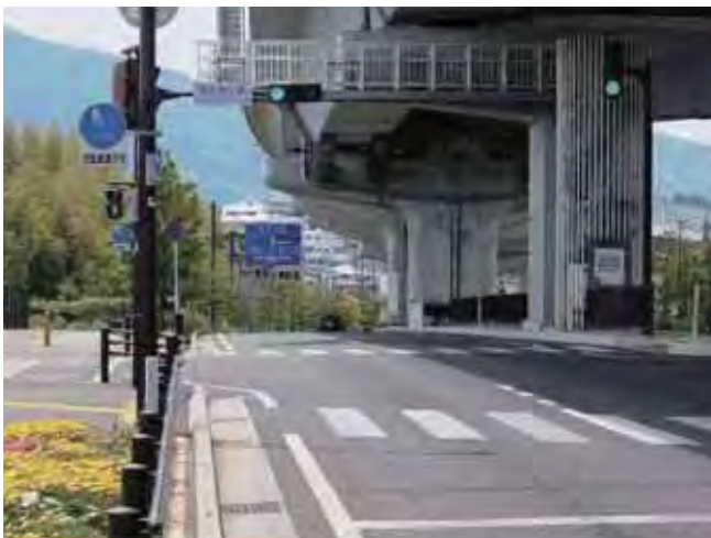
▲平成外環通り
