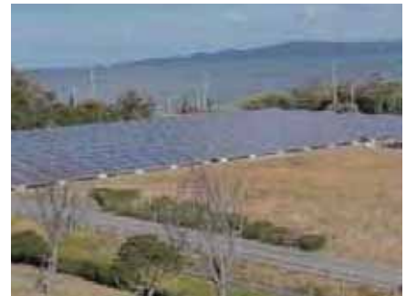
▲大原メガソーラー発電所
