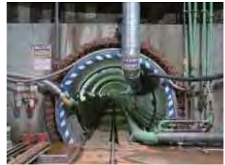
▲浸水対策(春吉3号幹線)
