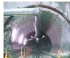
◆雨水排水機能の強化 (雨水管渠の整備)
