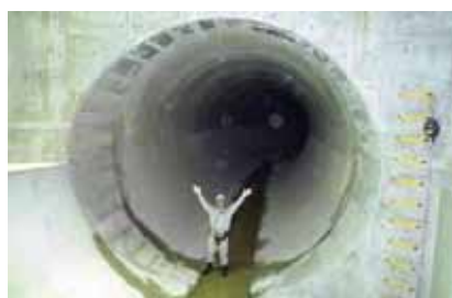
▲ 雨水管渠（比恵9号幹線）
