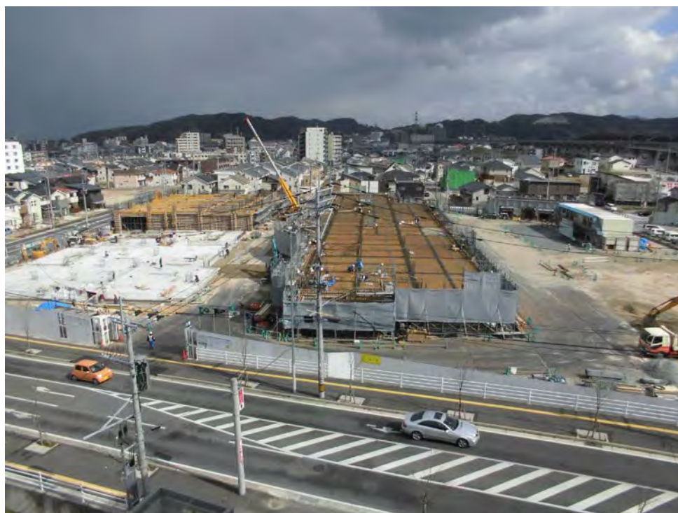
校舎側（敷地北側）全景（西側から撮影・2月末時点）
