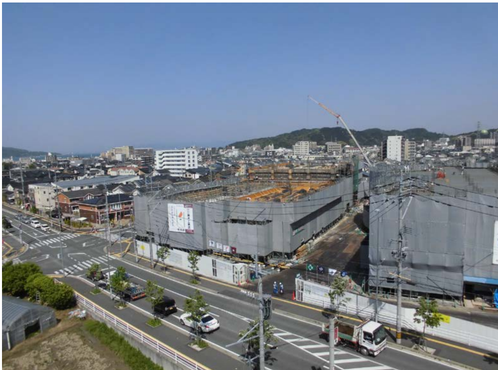
校舎側（敷地北側）全景（西側から撮影・4月末時点）
