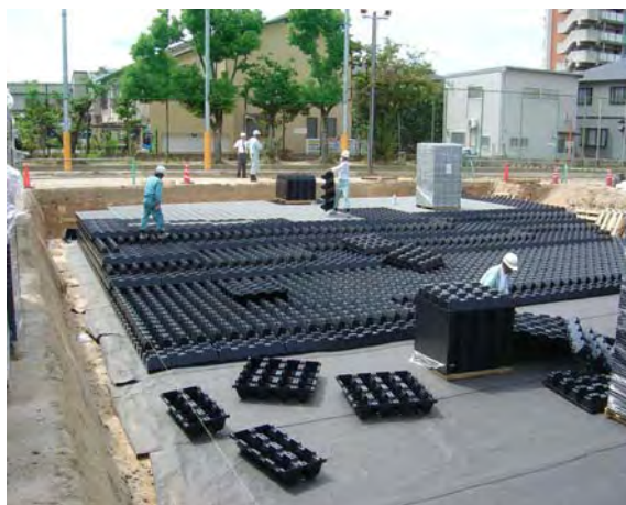
写真 板付北小学校雨水調整池設置状況
