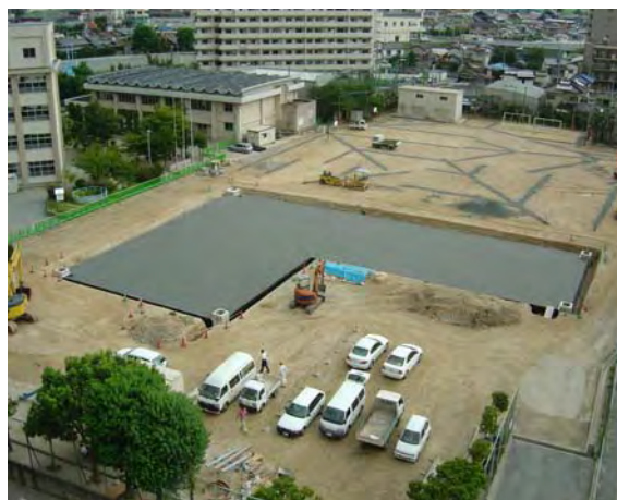
写真 板付北小学校雨水調整池設置状況
