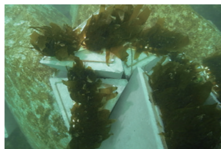
種糸付三角錐ブロック沈設による藻場造成
