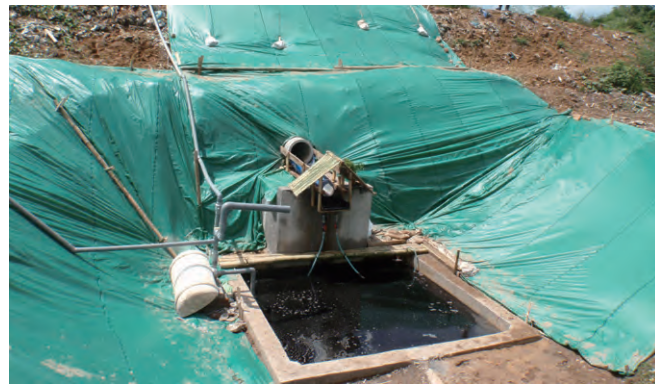
浸出水調整池 トルネード設置※(2012年) ※浸出水に渦を作り空気と混合し調整池を攪拌する装置
