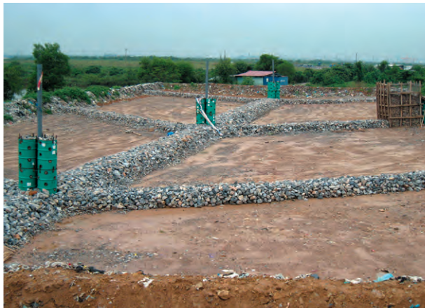
ハイフォン市ディンブー埋立場 福岡方式による改善状況(2011年)
