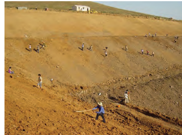
遮水シート施工前の法面の整形(2002年)
