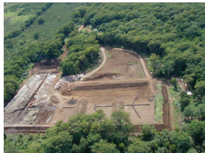
福岡方式に改善中の埋立場(2003年)
