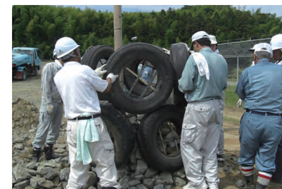
廃タイヤを利用した堅型ガス抜き施設の施工実習(2008年)
