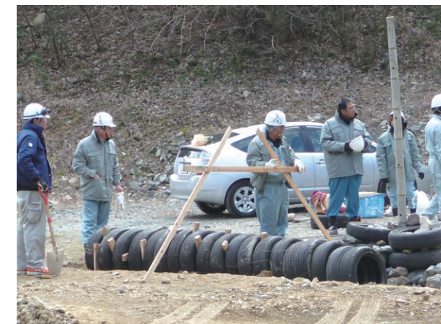
廃タイヤを利用した浸出水集排水管の施工実習
