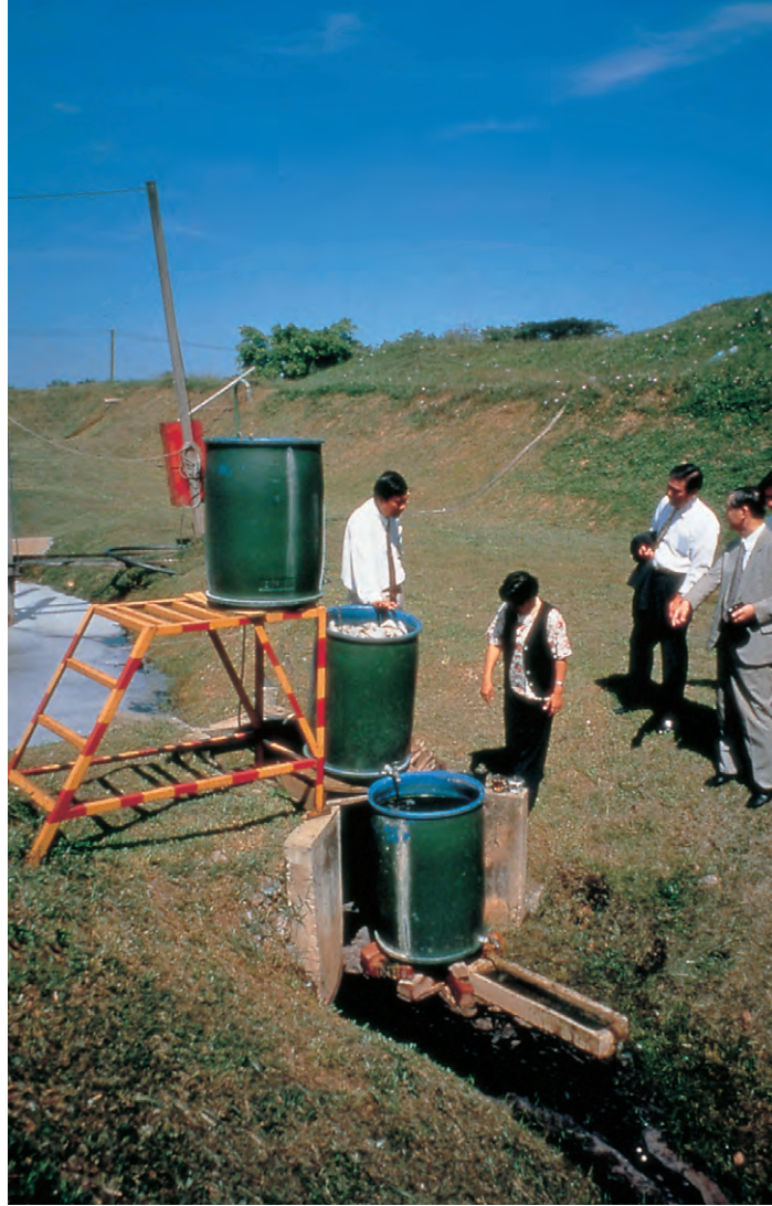
浸出水処理設備(パイロットプラント)
