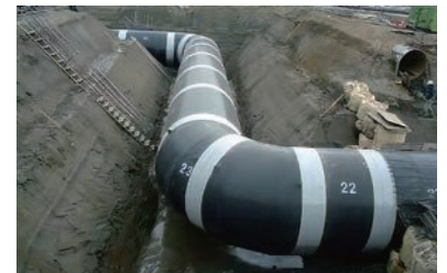
鋼管(耐震管)による布設状況 写真提供：日本水道鋼管協会
