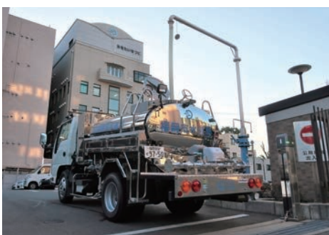
注水設備と給水車
