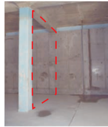
耐震壁設置前
