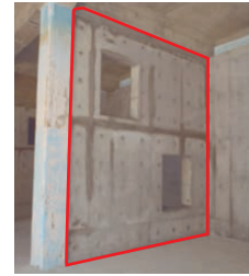
耐震壁設置後
