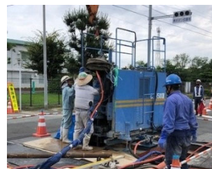
地盤改良状況
