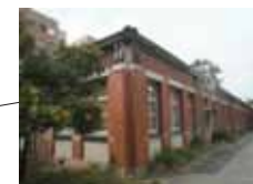
船舶海洋工学実験室 (大正10年建築)
