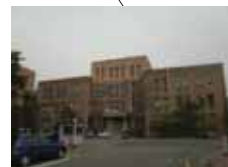
応用物質化学機能教室 (昭和2年建築)
