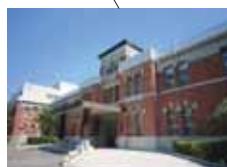
本部第一庁舎 (大正14年建築)
