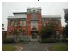
本部第三庁舎 (大正14年建築)
