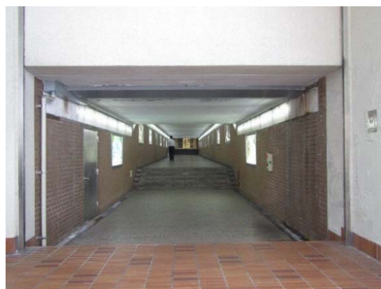
写真 5.6.2 渡辺通り地下通路
