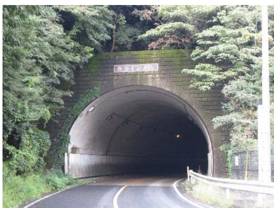
写真 5.3.1 山岳トンネル (N A T M) (長谷トンネル)
