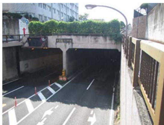
写真 5.3.2 開削トンネル (筑紫丘トンネル)
