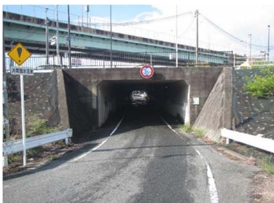
写真 5.4.1 松島アンダーパス① (管理対象は照明施設のみ)
