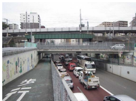
写真 5.4.2 美野島アンダーパス (施設全体管理)
