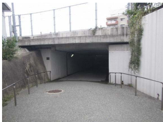
写真 5.6.1 名島地下通路
